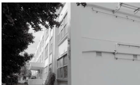
小学校の外壁
