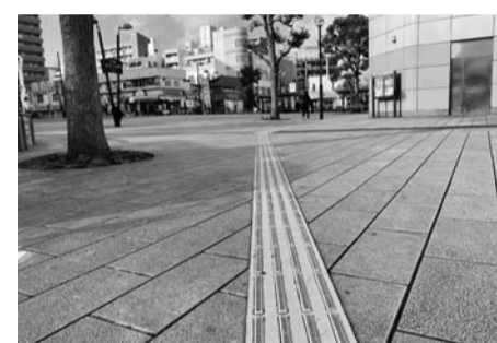
点字ブロックで安全に誘導
