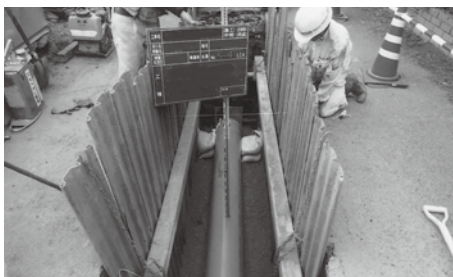
下水工事施工確認の様子
