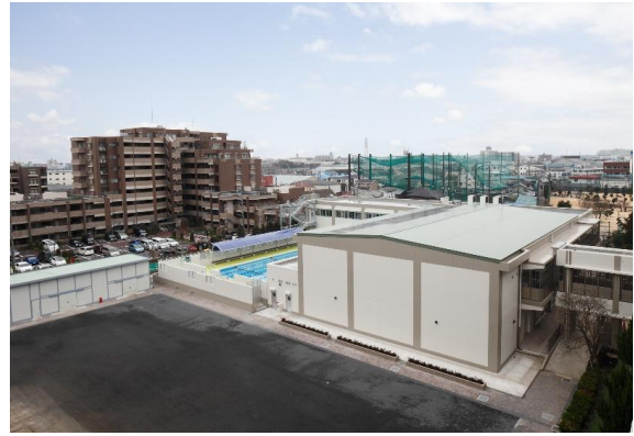
緑野小学校体育館特別教室棟建替工事
