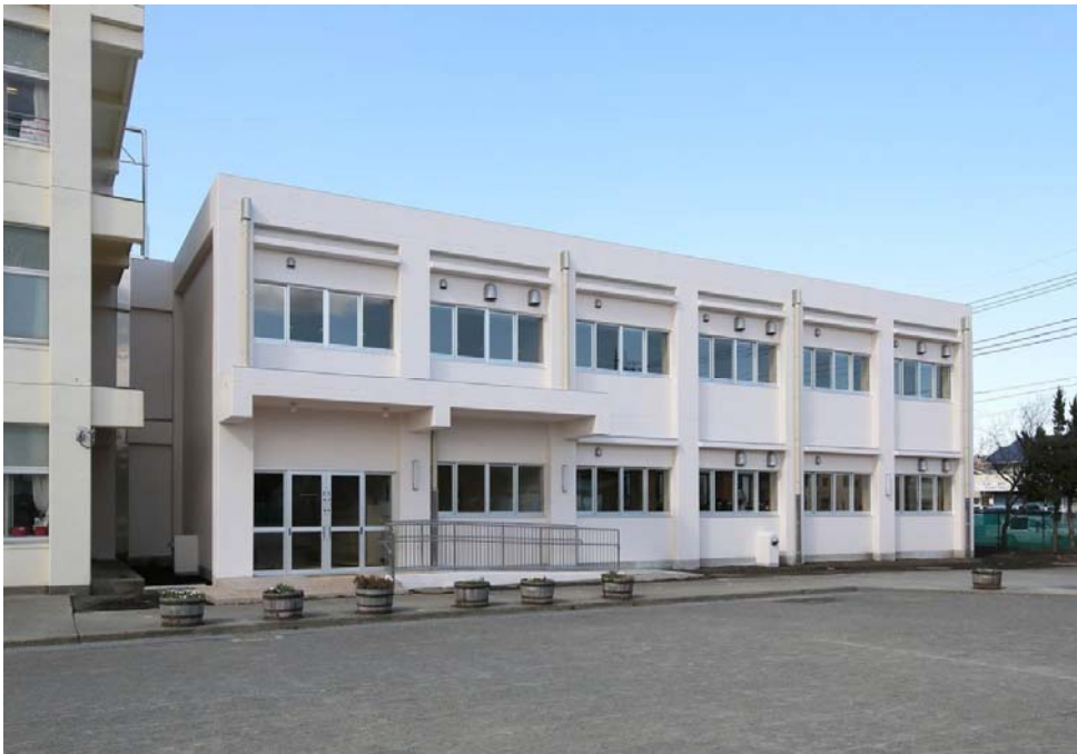
文ヶ岡小学校 増築工事（南側から撮影）
