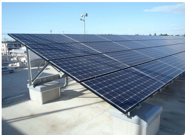
文ヶ岡小学校 増築工事（太陽光発電）
