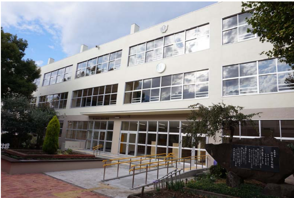
渋谷小学校 大規模改修工事（南側から撮影）
