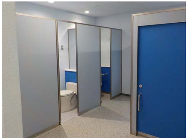
深見小学校 トイレ改修工事
