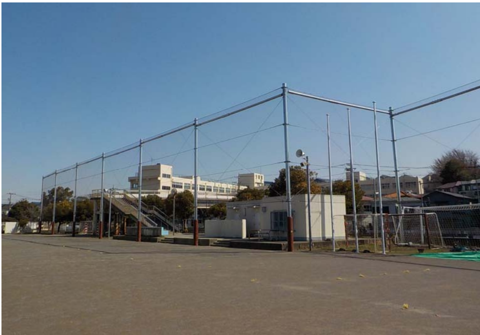
下福田中学校 防球ネット設置工事
