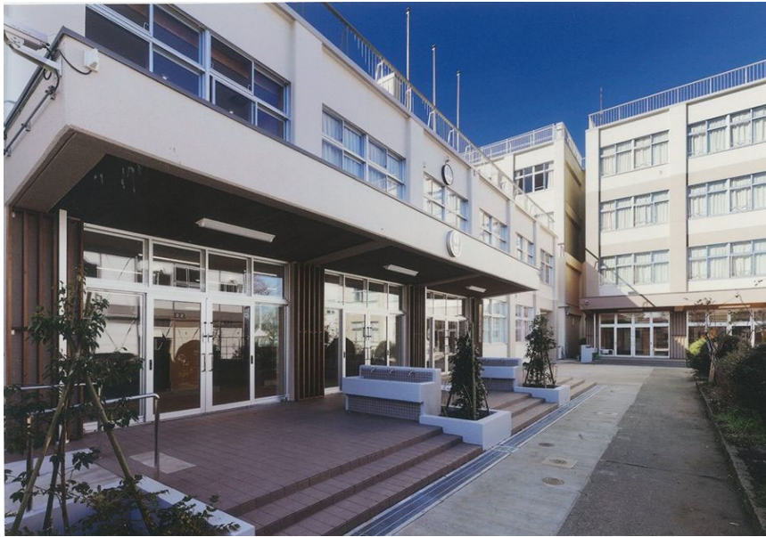
鶴間中学校 大規模改修工事
