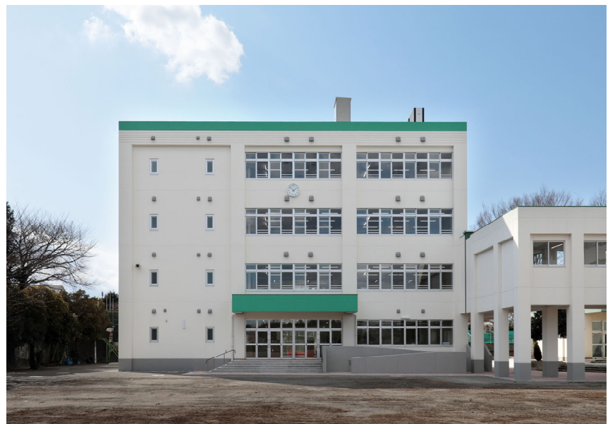
中央林間小学校 増築工事
