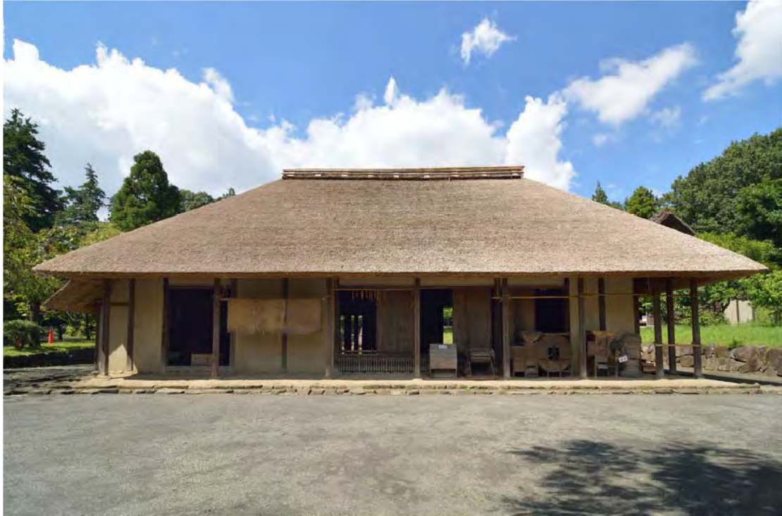
郷土民家園旧小川家住宅 完成した茅葺屋根(令和3年9月小林恵撮影)
