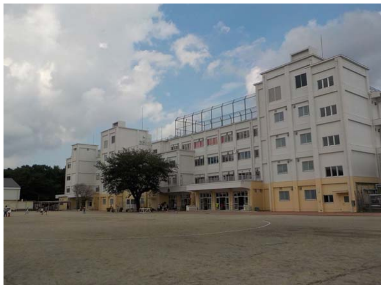
大野原小学校 大規模改修工事（校庭整備）
