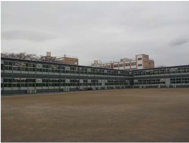
鶴間中学校 大規模改修工事（仮設校舎）
