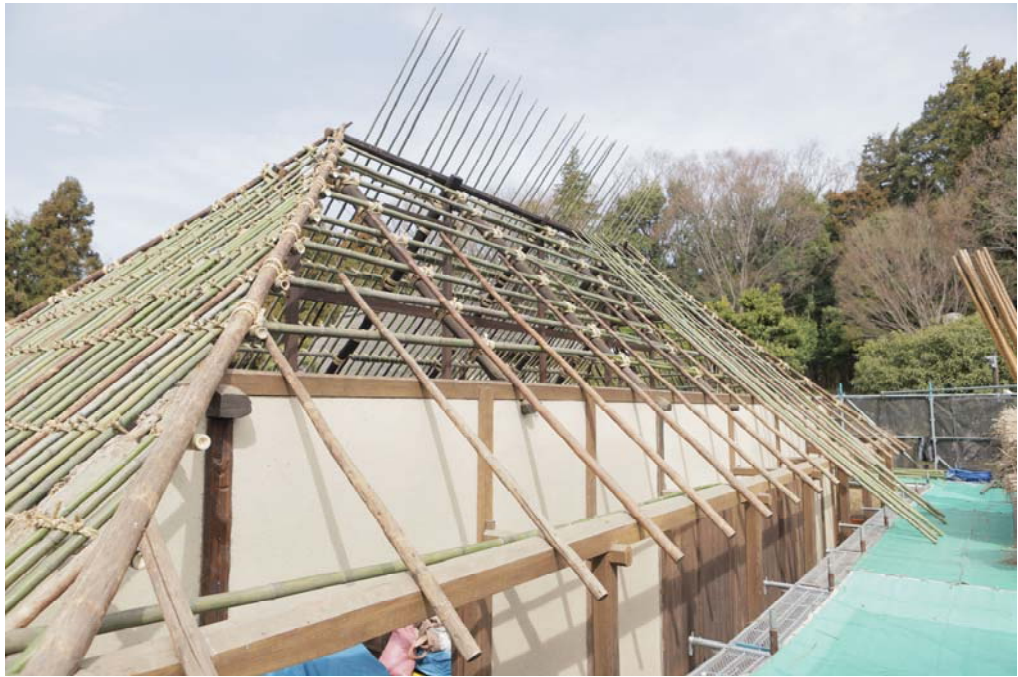
郷土民家園旧小川家住宅 屋根茅の全面葺き替えの様子(令和3年3月)
