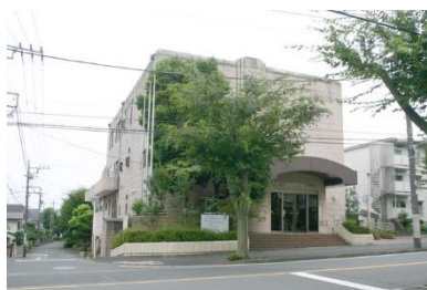
つきみ野学習センター (改修工事前)
