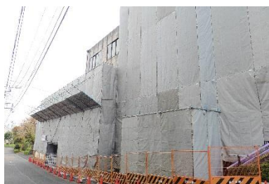
つきみ野学習センター (改修工事中)
