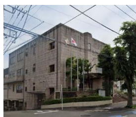
つきみ野学習センター (改修工事前)
