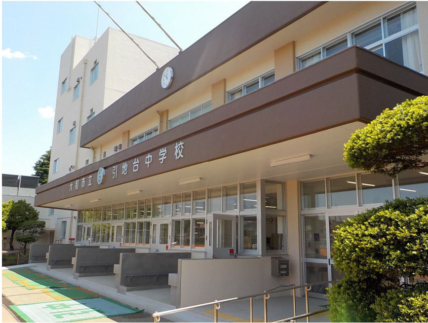
引地台中学校 大規模改修工事
