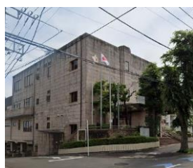
つきみ野学習センター (改修工事前)
