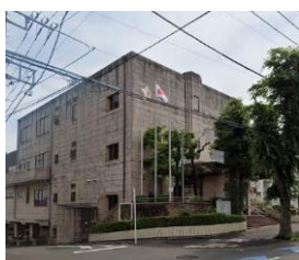
つきみ野学習センター (改修工事前)
