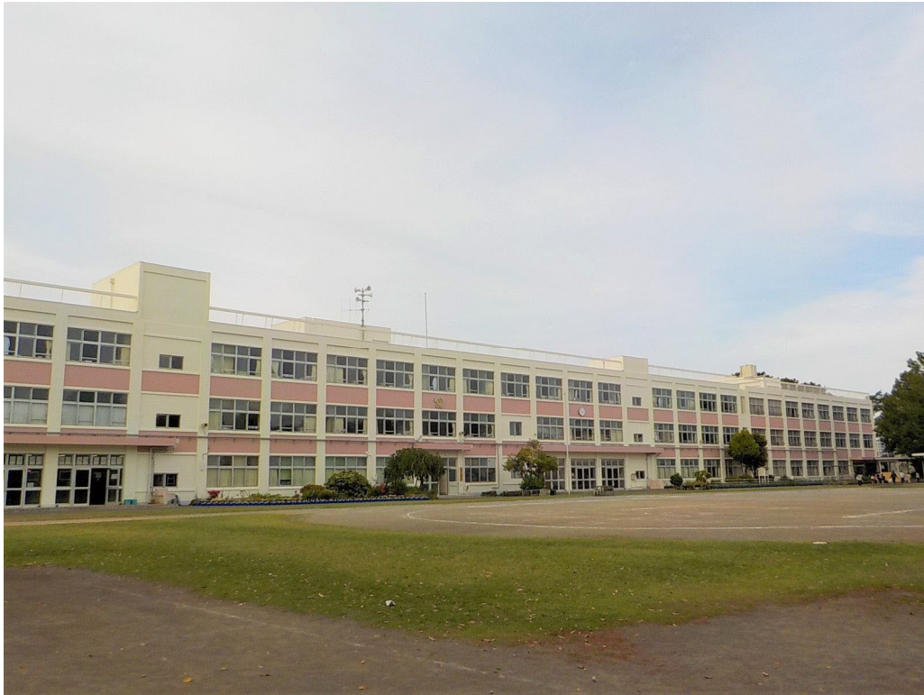
深見小学校屋上外壁改修工事
