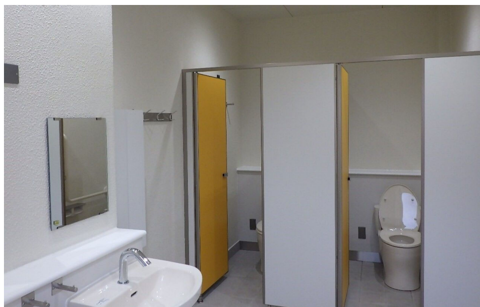
引地台小学校外トイレ改修工事
