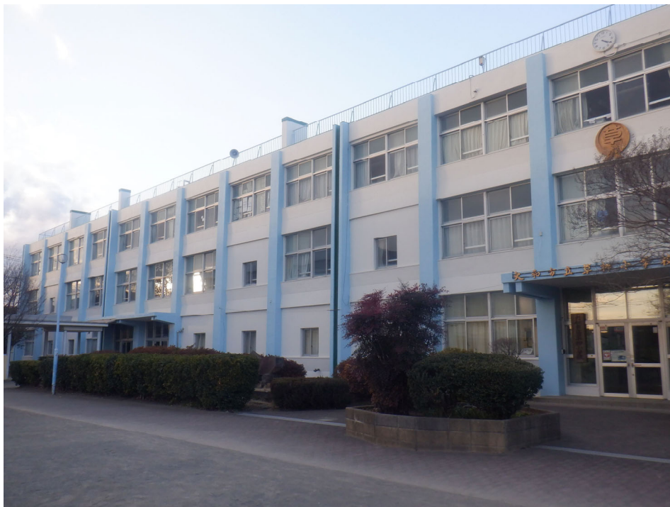
草柳小学校外壁塗装改修工事
