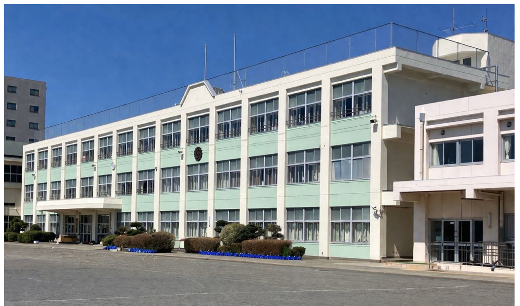
市立文ヶ岡小学校屋上外壁改修工事
