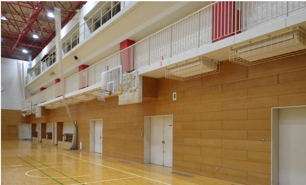
市立光丘中学校屋内運動場空調設備設置工事
