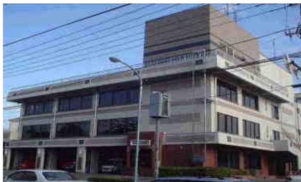
消防本部・消防署（本署）庁舎
