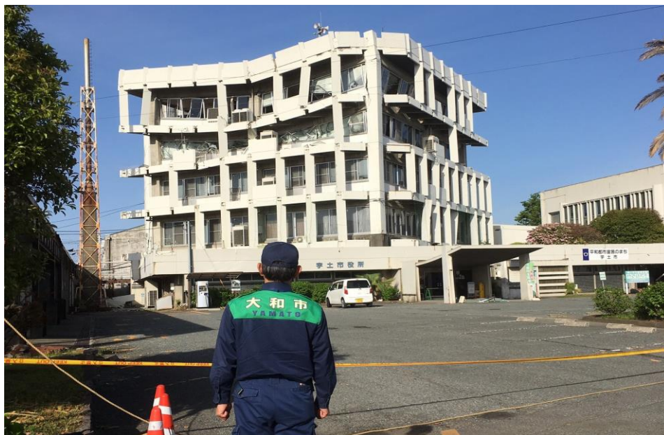
【損壊した宇土市役所庁舎 平成 28 年 4 月 17 日撮影】
