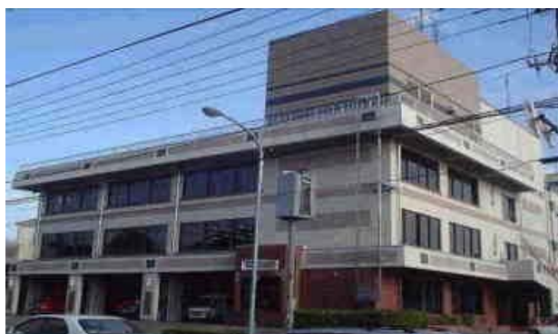
消防本部・消防署（本署）庁舎
