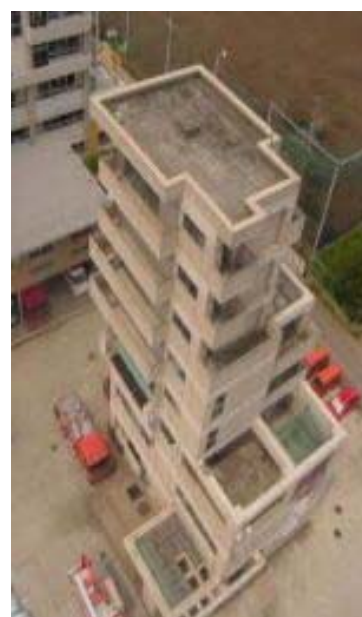
消防防災訓練センター
