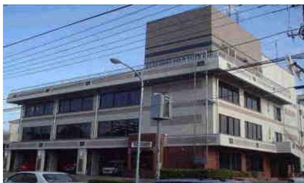
消防本部・消防署（本署）庁舎
