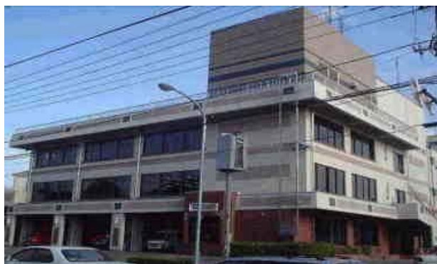
消防本部・消防署（本署）庁舎
