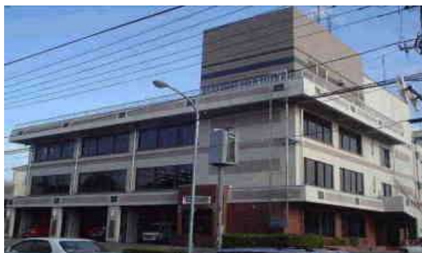
消防本部・消防署（本署）庁舎
