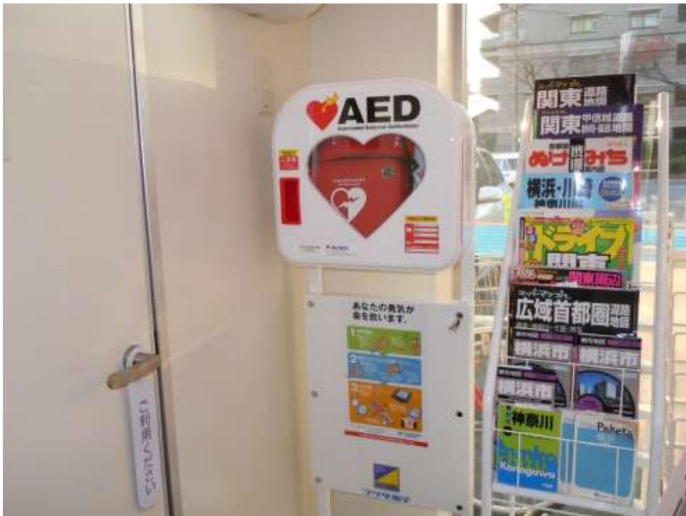
【コンビニエンスストアへのAED設置状況】
