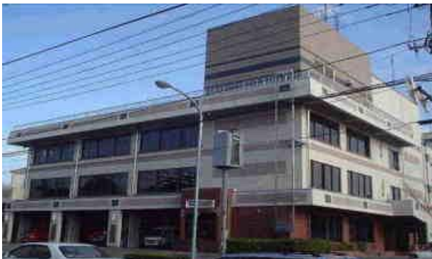
消防本部・消防署(本署)庁舎
