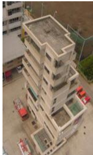
消防防災訓練センター
