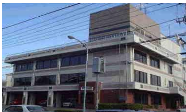
消防本部・消防署（本署）庁舎
