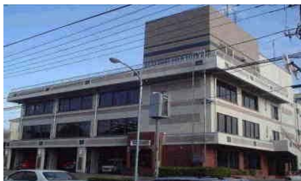
消防本部・消防署（本署）庁舎
