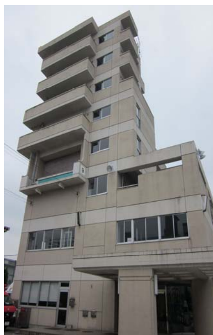
消防防災訓練センター
