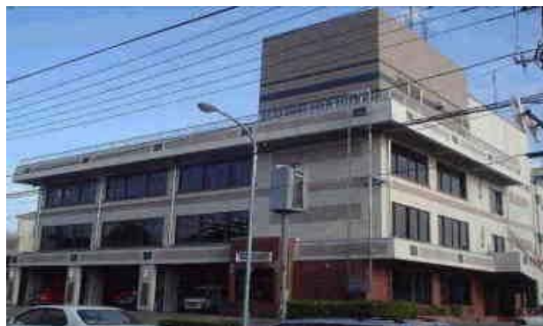
消防本部・消防署（本署）庁舎
