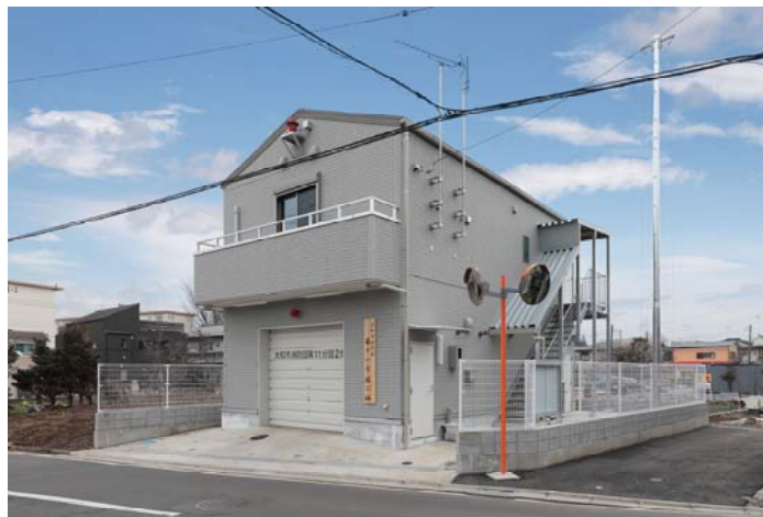
【令和元年度新築 第 11 分団 2 班車庫詰所】
