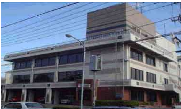
消防本部・消防署（本署）庁舎
