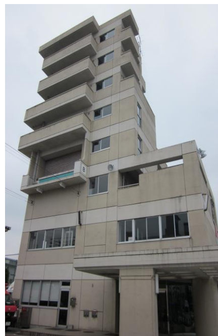
消防防災訓練センター
