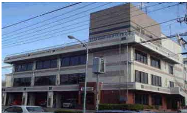
消防本部・消防署（本署）庁舎
