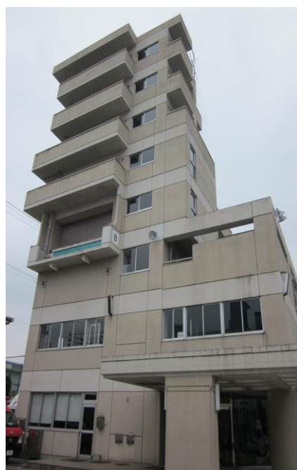
消防防災訓練センター
