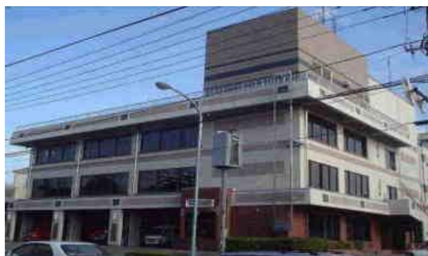
消防本部・消防署（本署）庁舎
