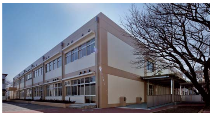
大和小学校屋内運動場 (平成22年度対象事業)
