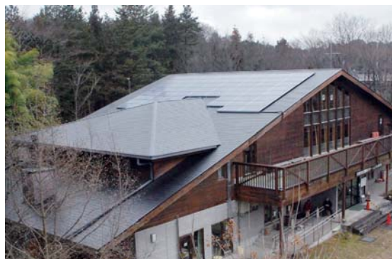
自然観察センター・しらかしのいえに設置した太陽光パネル
