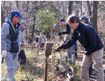
カントリーヘッジの補修
