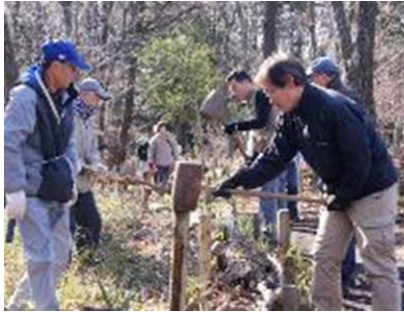
カントリーヘッジの補修
