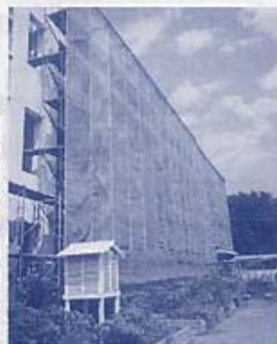
耐震補強工事中の校舎 (昨年7月深見小学校)
