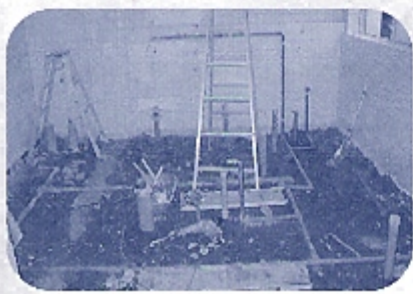
改修工事中のトイレ
