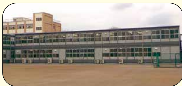
鶴間中学校 仮設校舎
