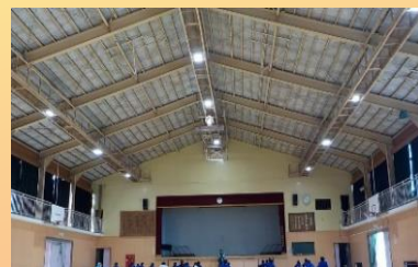
鶴間中学校体育館
