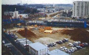
建設中の新渋谷中学校校舎
