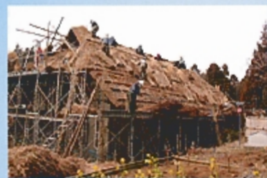
茅葺屋根を葺き替えている様子
