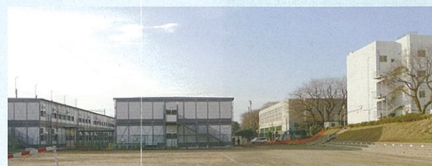
※仮設校舎(左)と大規模改修される校舎(右)
